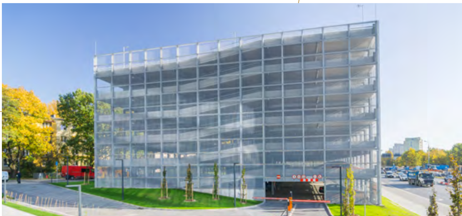
Parking wielopoziomowy dla PH Astrum w Łodzi. Powierzchnia zabudowy 2.000m 2 na 13 kondygnacjach, 341 miejsc postojowych.
