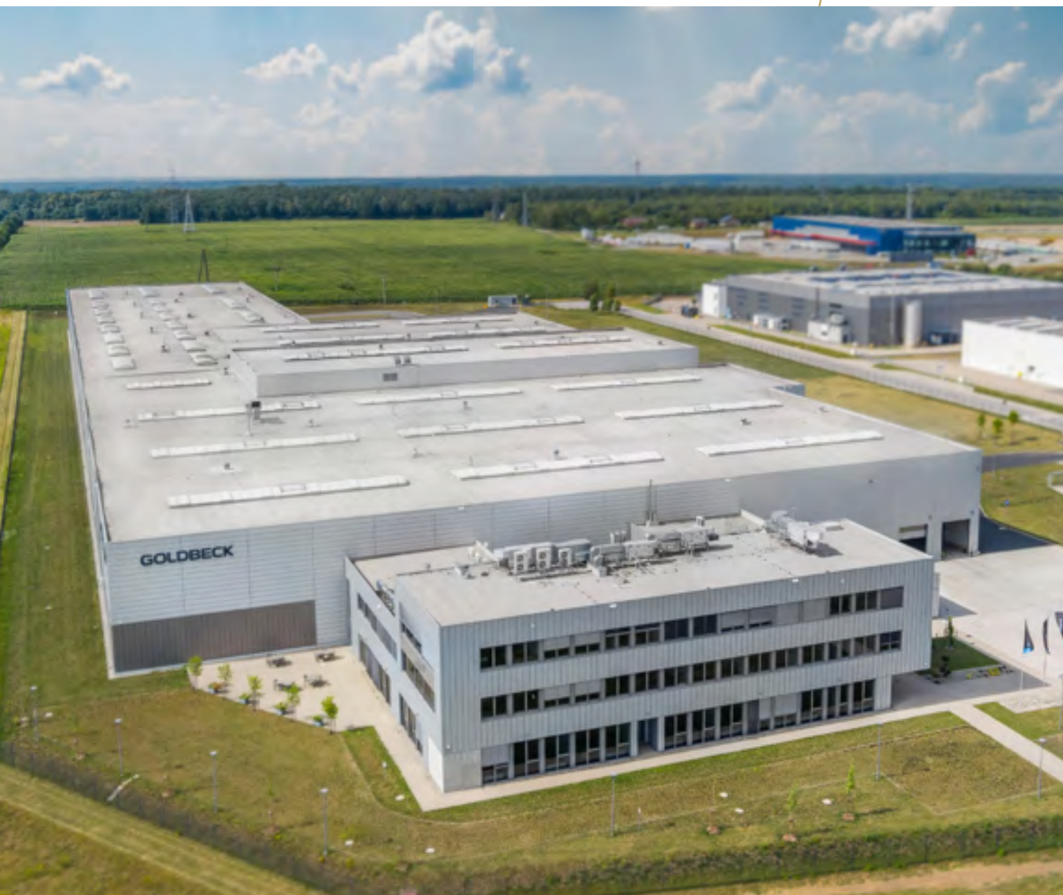
Hala produkcyjna GOLDBECK Elementy w Lućmierzu, produkcja konstrukcji stalowych.
