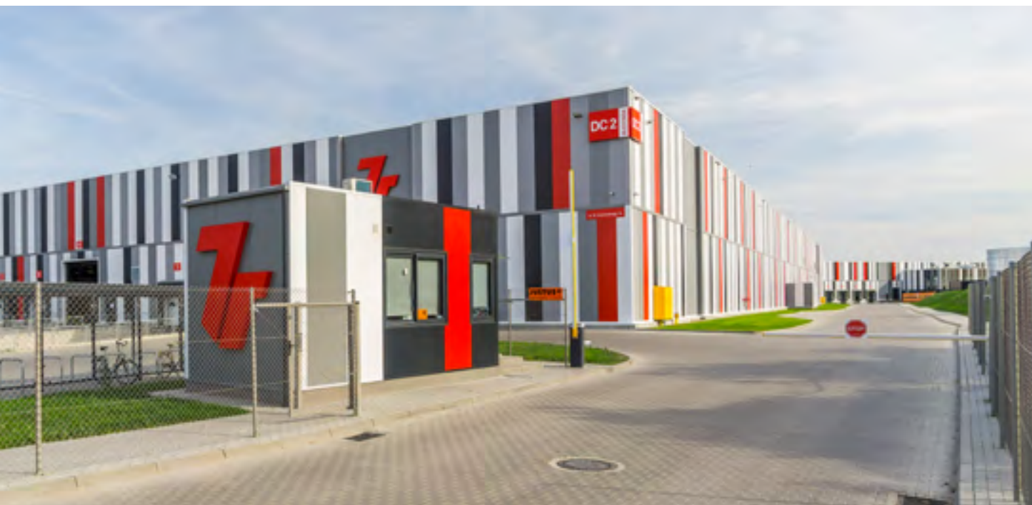
Hala logistyczna dla 7R w Poznaniu. Powierzchnia: 31 000 m 2 hala + 1000 m 2 biura.
